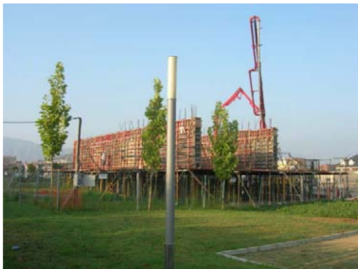
Vista General de la obra.
