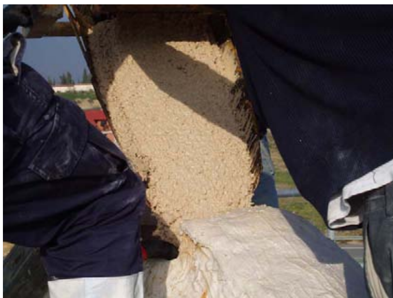
Detalle vertido de Hormigón.
