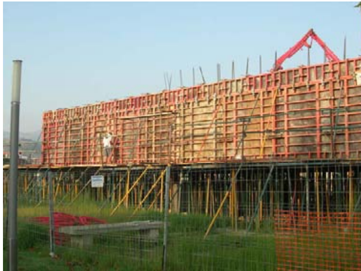
Hormigonado de la pieza
