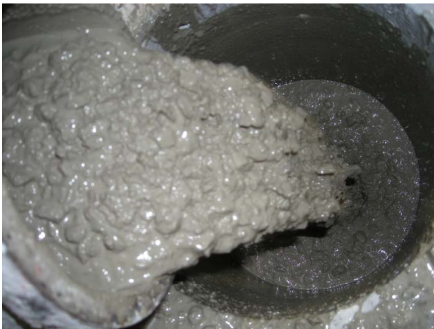
Hormigonado bajo la losa con Hormigón autocompactante.
