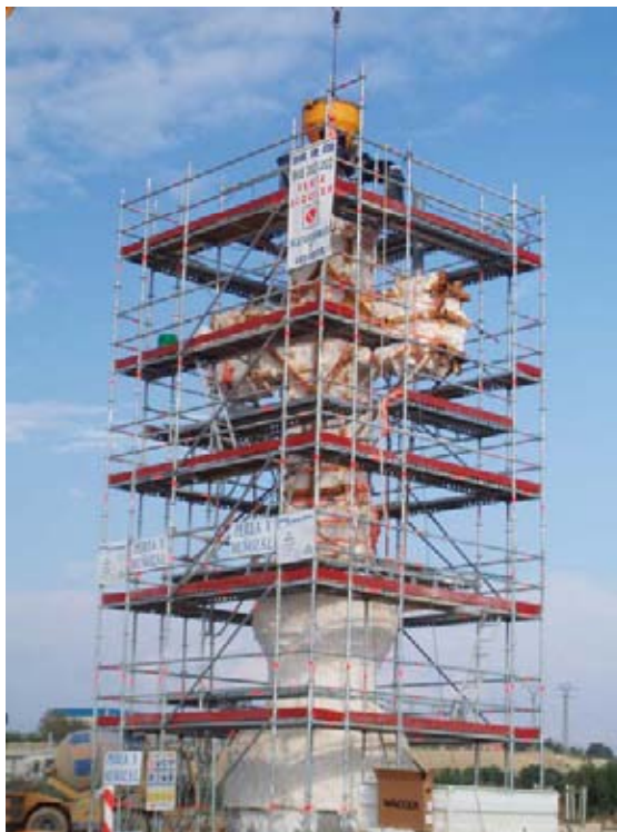
Hormigonado de la pieza.
