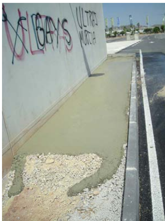
Avance del hormigón Autocompactante
