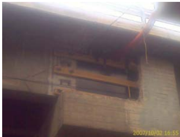
Preparación del punto de hormigonado.
