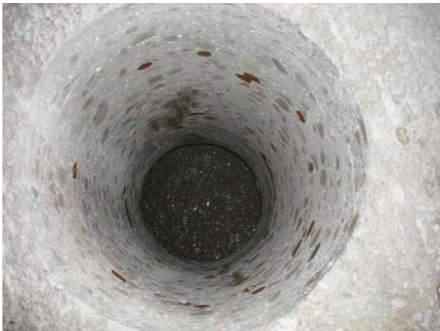
Paso de Hormigón bajo la losa
